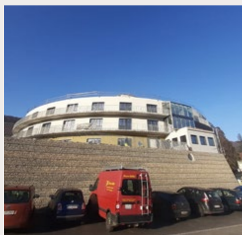
Die Baustelle des Heims Les Bouleaux in Corgémont.
