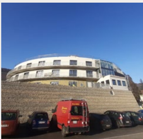
Chantier du home Les Bouleaux à Corgémont.
