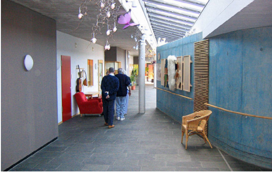
Verrière de toit installée dans un service de démence (Maison Gradmann, Stuttgart).
