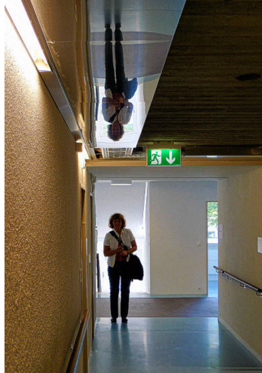
Reflets sur le conduit de ventilation, au plafond, dans le couloir d'un EMS.
