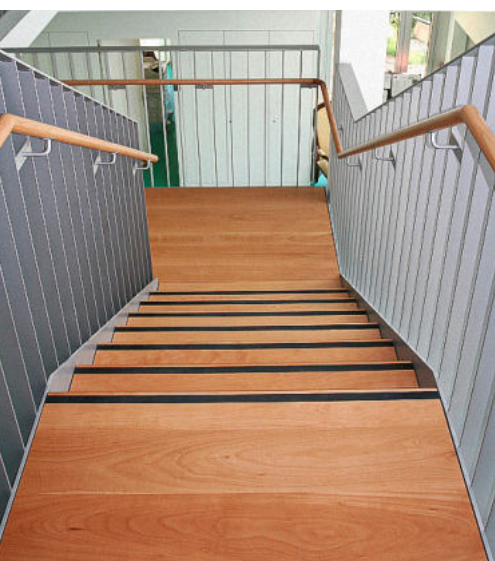
Einfarbige Treppen mit kontrastreichen Stufenkanten erleichtern die Erkennung und sichere Nutzung der Treppe.
